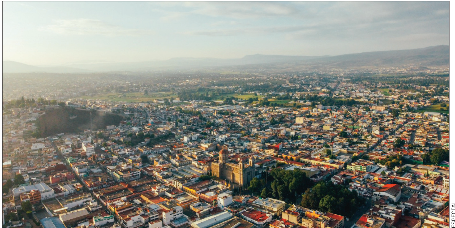
HECHOS. La rehabilitación del cuerpo derecho del corredor vial San José será de gran beneficio, tanto para la población local como para visitantes.
