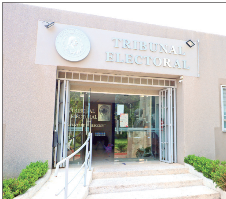
BASES. A finales del año pasado, difundieron dos procedimientos de adjudicación directa para obras físicas en el inmueble que alberga al órgano jurisdiccional, ubicado en carretera federal México-Pachuca, kilómetro 84.5 colonia Sector Primario.
