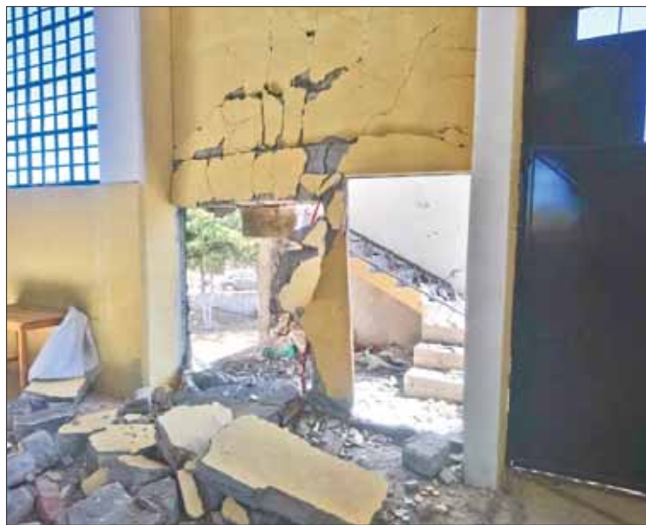
CALOR. Los fuegos artificiales eran almacenados dentro de una bodega sin la menor medida de seguridad.
