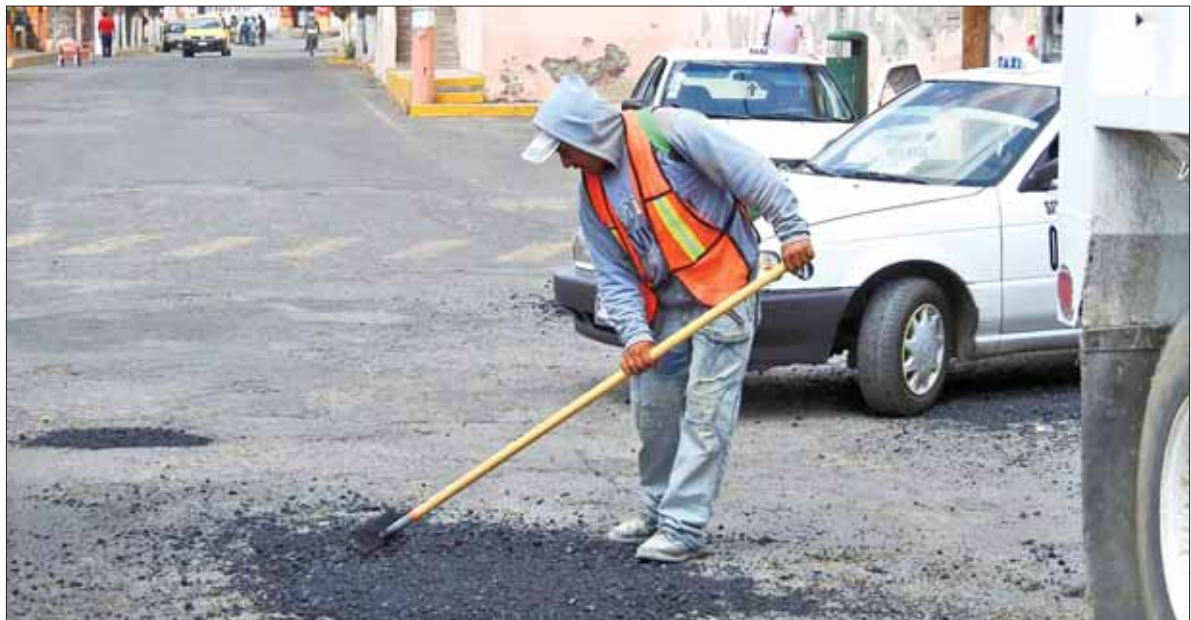
PUNTOS. Recomendación para la ciudadanía es evitar la descarga descontrolada de agua a la vía pública.
