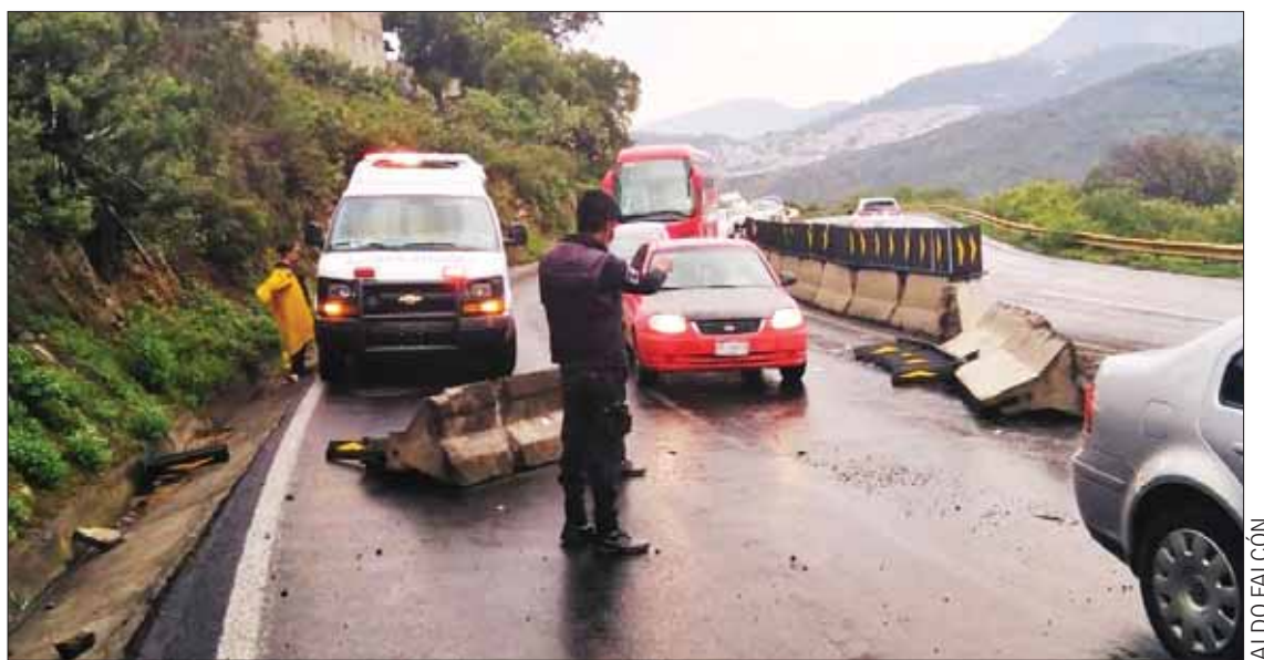
Debido a un accidente en el Corredor de la Montaña, donde el conductor del vehículo implicado huyó, las guarniciones del muro de contención fueron derribadas ocasionando bloqueo parcial en un carril; personal de Protección Civil de Mineral de la Reforma acudió al lugar para el retiro del material y realizar el abanderamiento necesario.
