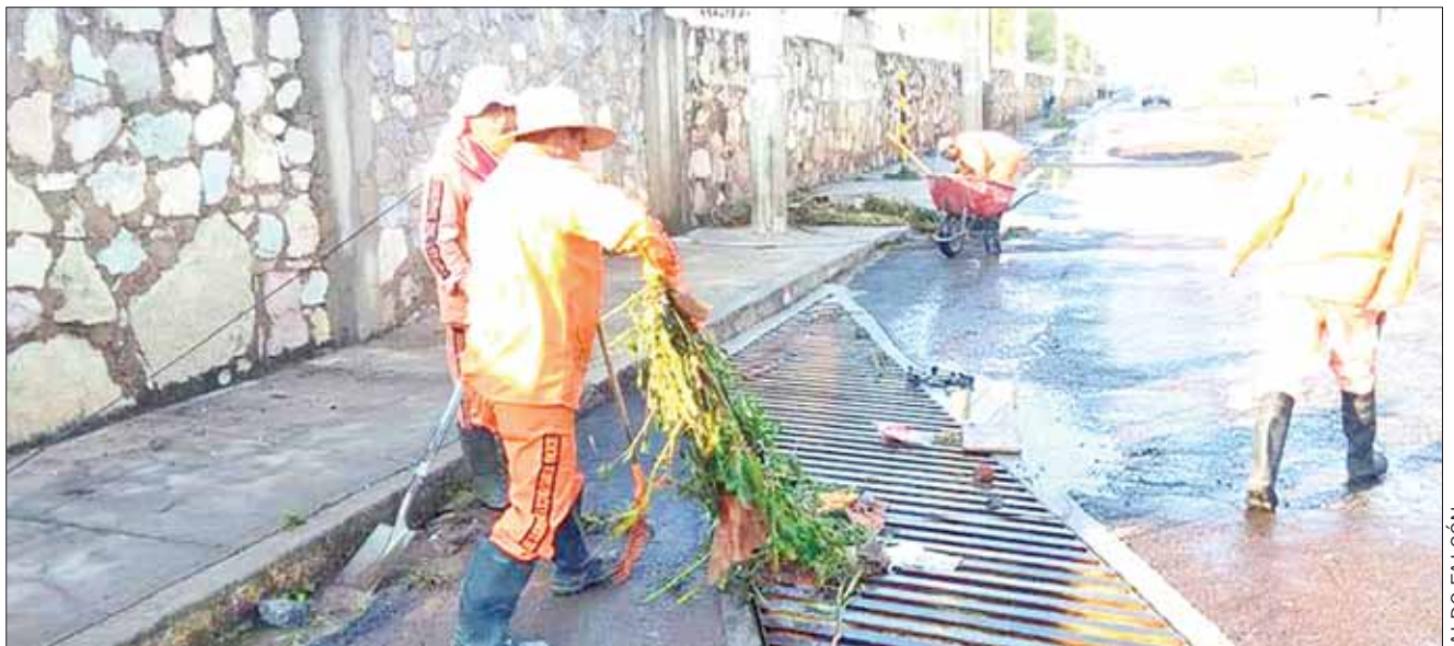
REALIDAD. Indicaron que en algunos puntos hubo serios taponamientos como consecuencia de los desechos.
