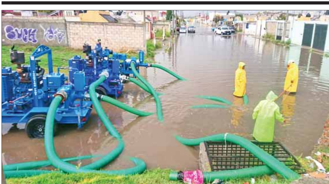
Realizó personal de Protección Civil y de la Caasim maniobras de desfogue en colonia Los Tuzos, donde las lluvias generaron anegaciones.
