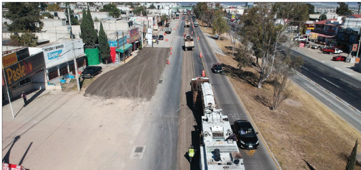
Realiza la Secretaría de Obras Públicas y Ordenamiento Territorial encarpamiento sobre la carretera México-Pachuca, lo cual brindará beneficios a los conductores.
