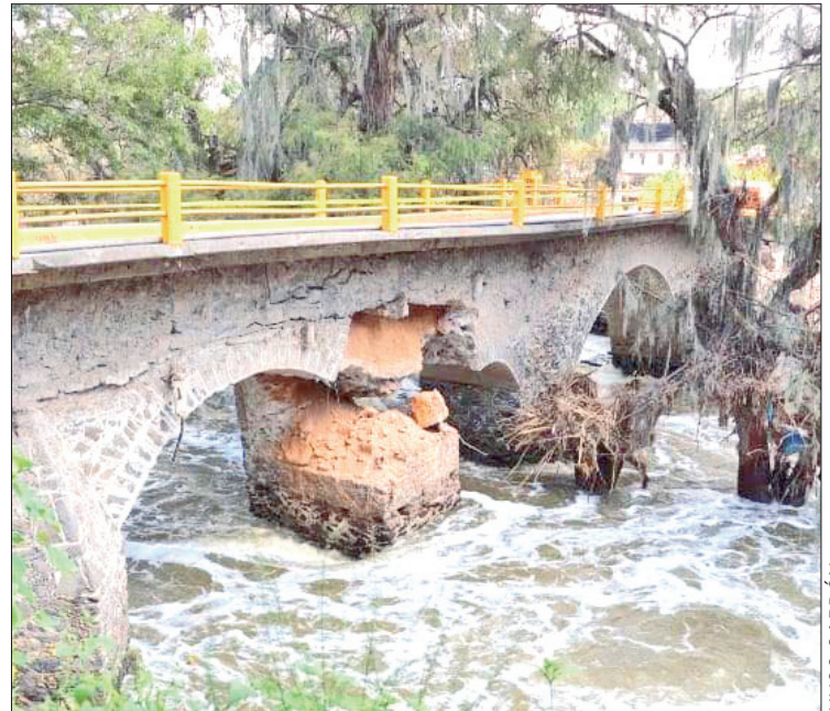
DIÁLOGO. Se realizó una mesa de trabajo donde se confirmó la reconstrucción total del puente ubicado en la localidad de Tlacotalpilco.
