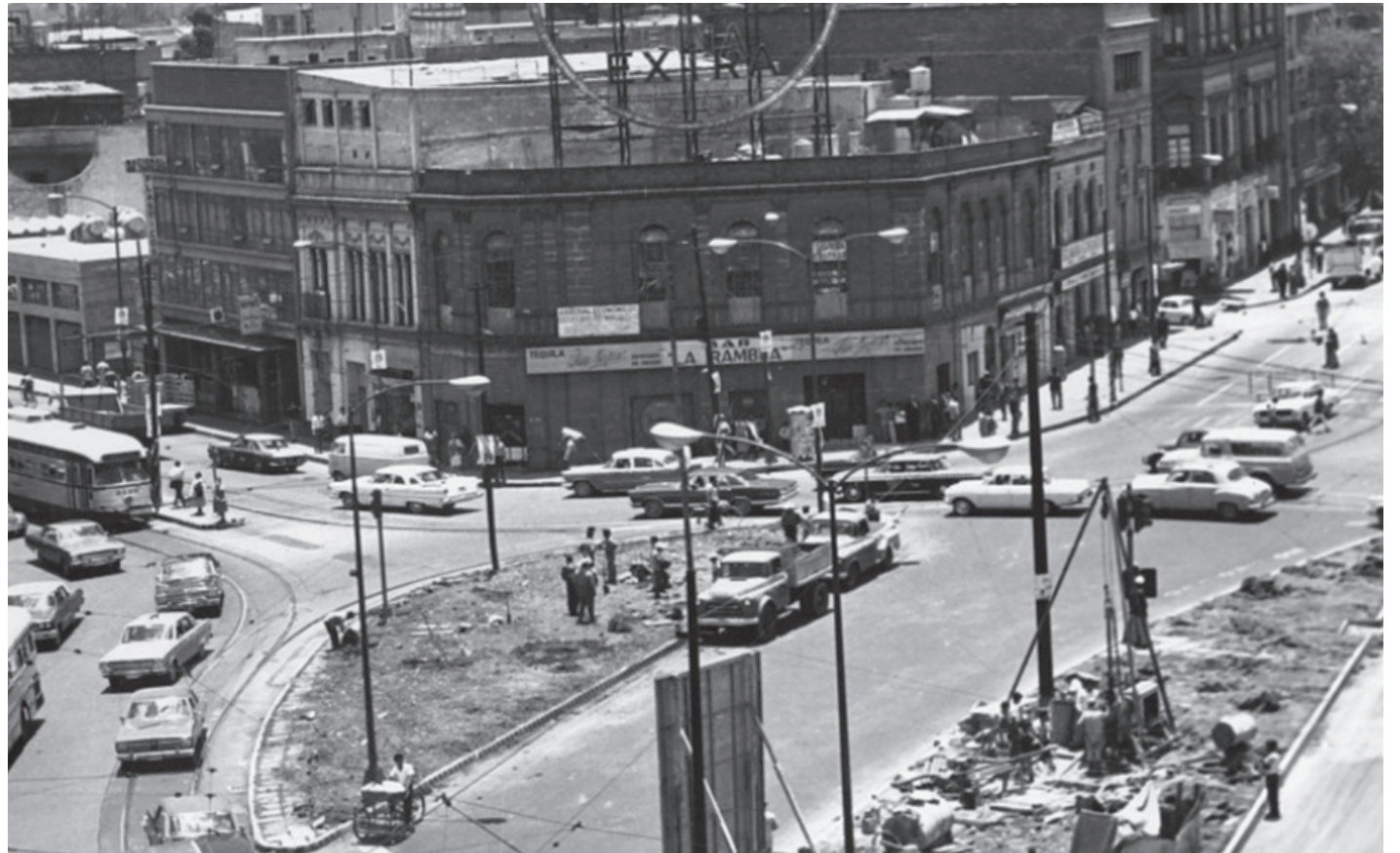
Al fondo, la cantina “La Rambla” en Avenida Chapultepec y Bucareli, testigo mundo del inicio de las obras de la Línea 1 del Metro.
