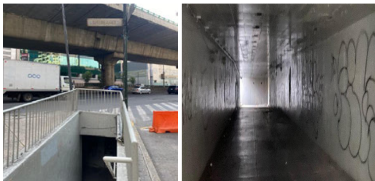
El paso peatonal carece de iluminación y es un riesgo para quienes lo utilizan.
