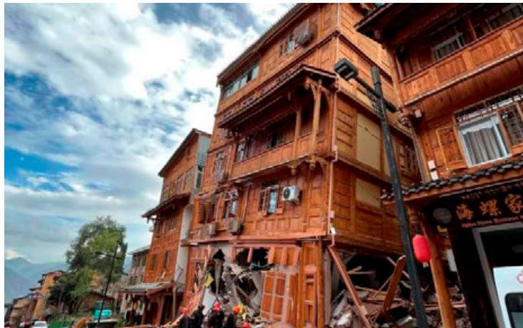
Edificio destruido por el sismo en el condado de Luding.
