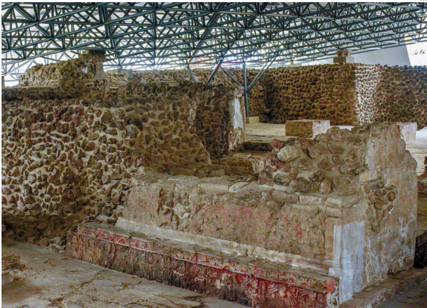
Una vista del nuevo techo de la Casa de las Águilas.
