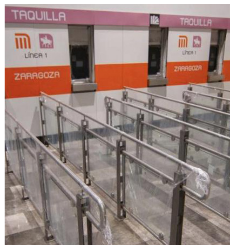
En febrero se terminará la obra civil.
