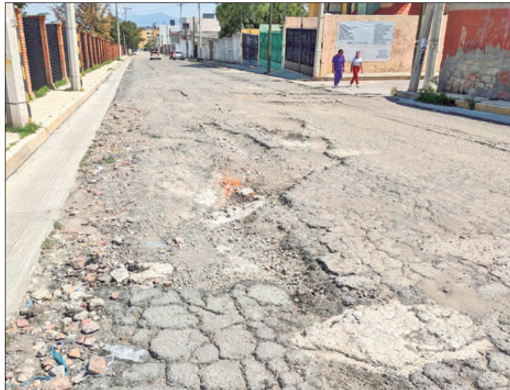
PERSPECTIVA. Habitantes del fraccionamiento Los Tuzos indicaron que es importante la cantidad de agua que se concentra y la aparición de nuevos baches.
