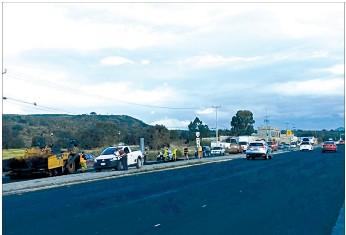
REPARACIONES. Las labores que comprenden el tramo de Xochihuacán al entronque con la comunidad de Nopalapa.
