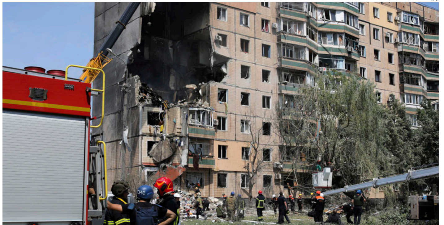
Equipos de rescate trabajan en un edificio dañado por el bombardeo ruso en Krivi Rig.
