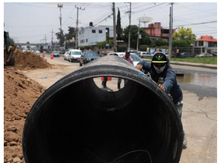
Obras en el Boulevard Ojo de Agua, en Tecámac.
