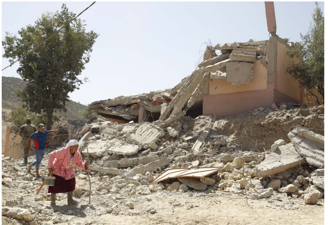
Una anciana camina entre los escombros en la aldea de Tafagajt, en Marruecos, cerca del epicentro del devastador terremoto.
