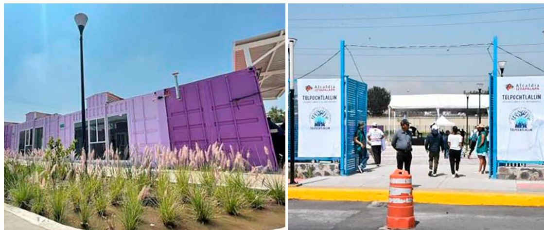
La alcaldesa Clara Brugada dio a conocer que la escuela fue edificada en un espacio de 10 mil metros cuadrados y las aulas se construyeron con contenedores industriales.
