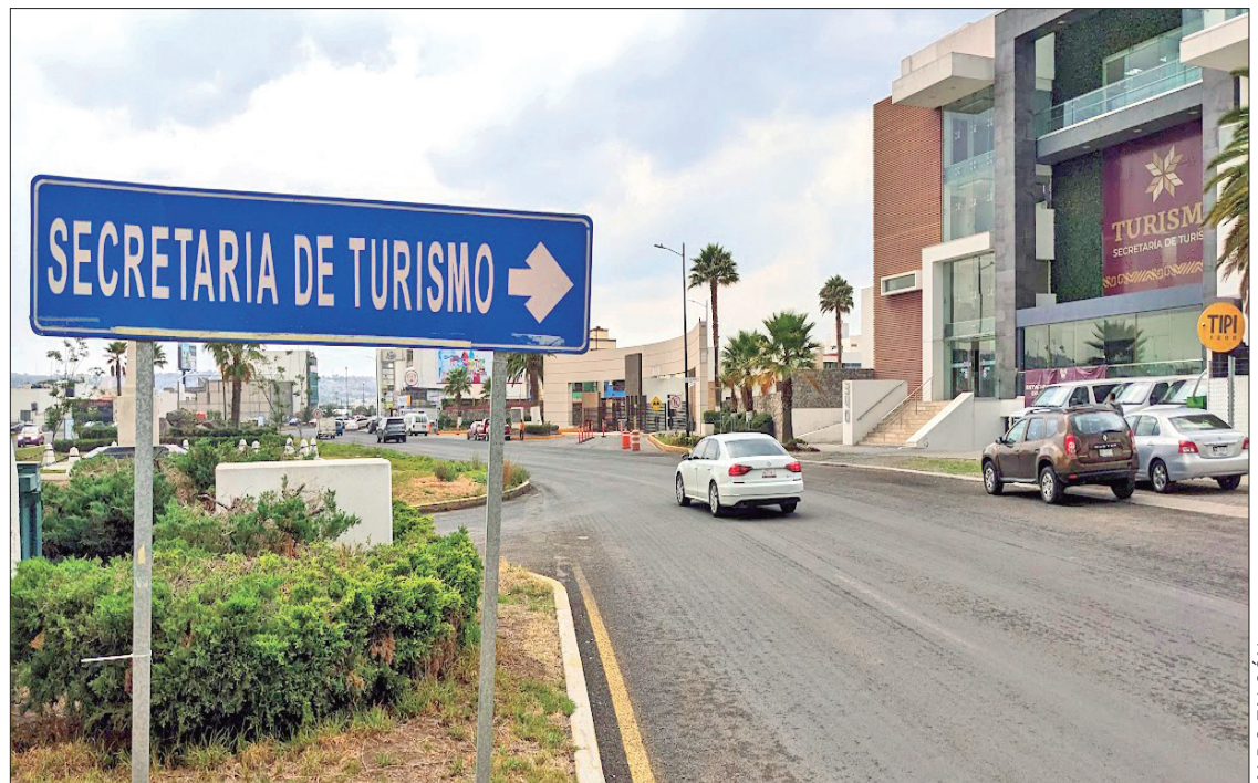
ESTRIBOS. Acciones centradas en optimizar estrategias de comunicación, preparación de instalaciones, orientación o contenidos.
