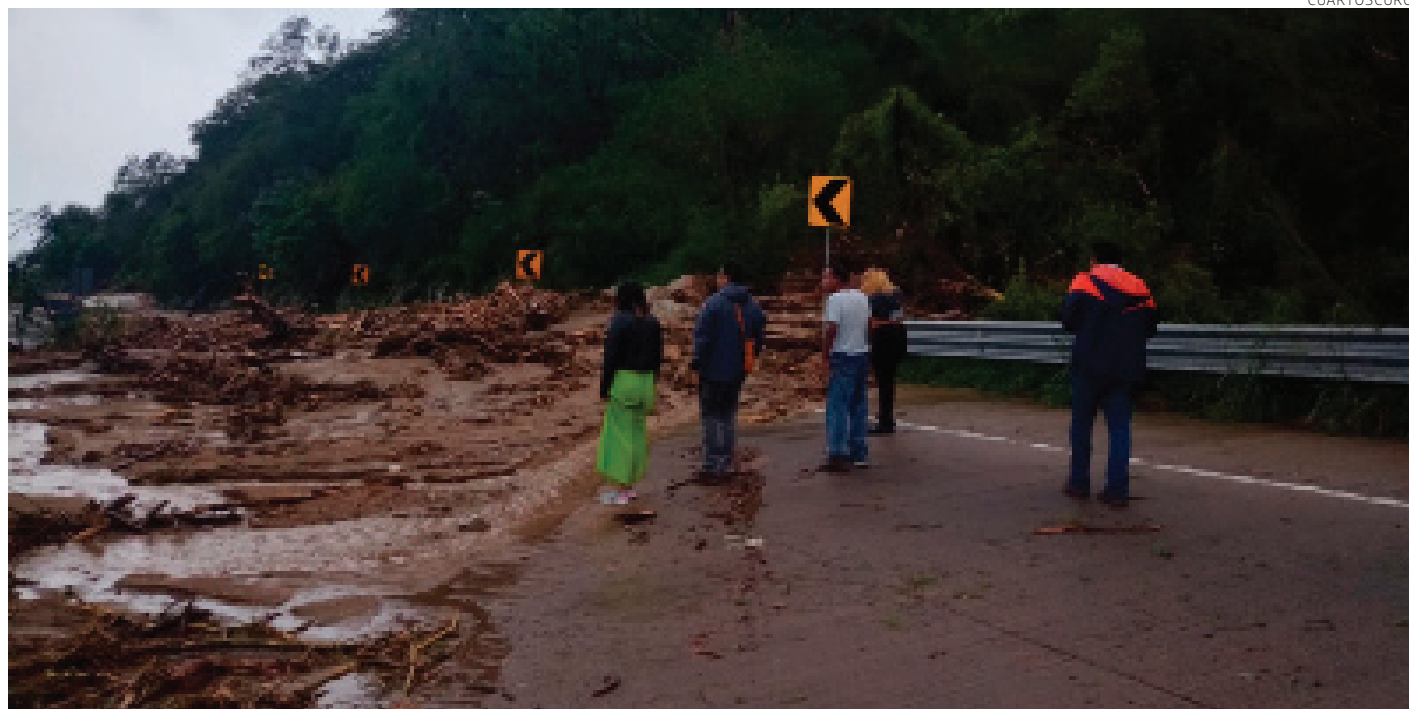
Destrozos en la Autopista del Sol tras el paso del huracán Otís por Guerrero.
