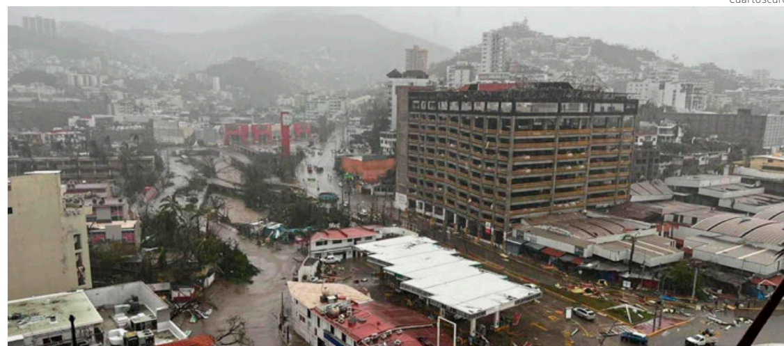
Plazas, hoteles y calles lucen destruidas tras la entrada del huracán Otis al puerto de Acapulco.
