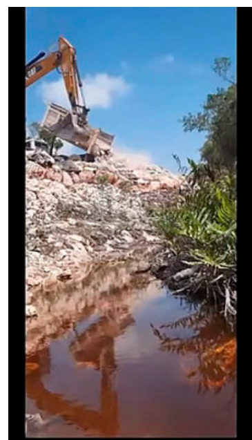
En el tramo 5 hay más de 120 cuevas impactadas, uso de explosivos para desmonte y la maquinaria tapó cenotes
