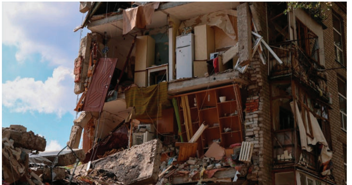
Imagen de archivo de un bloque de viviendas destruido en un bombardeo en Avdivka.
