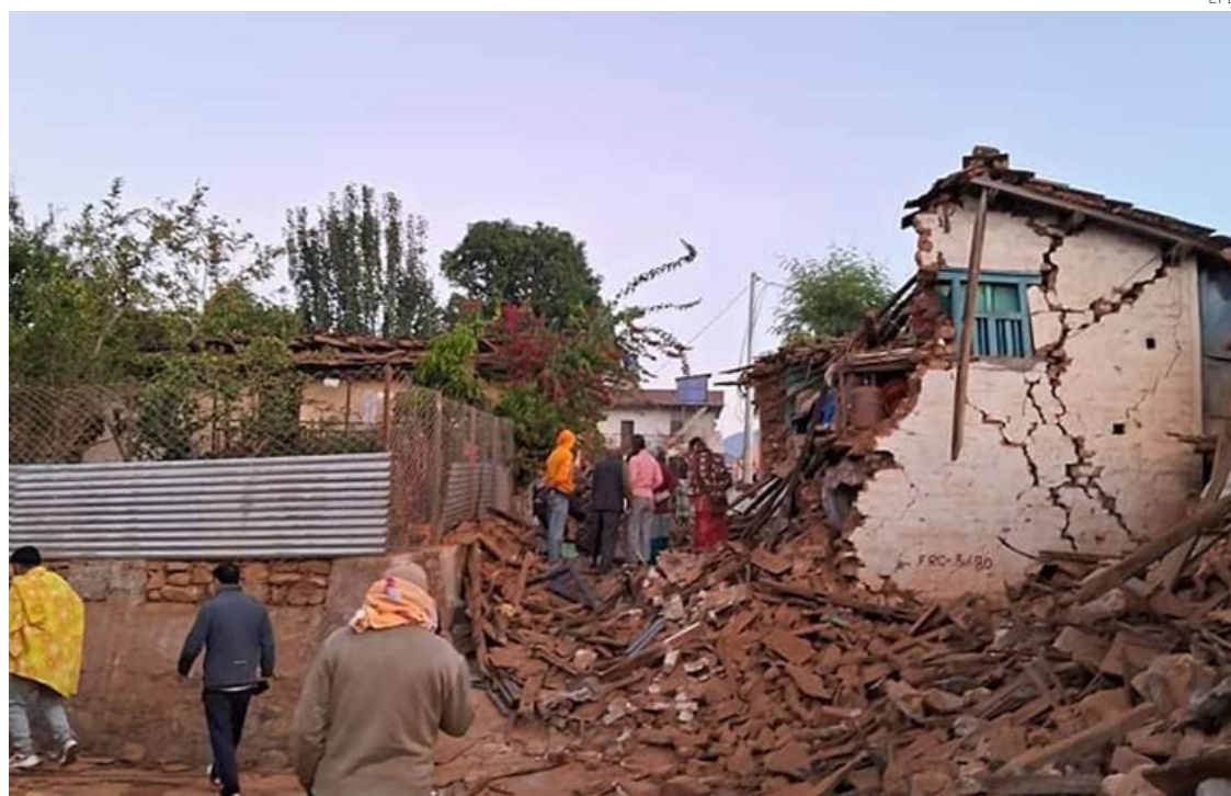
El rastro del terremoto se aprecia en casas dañadas cerca de Jajarkot.
