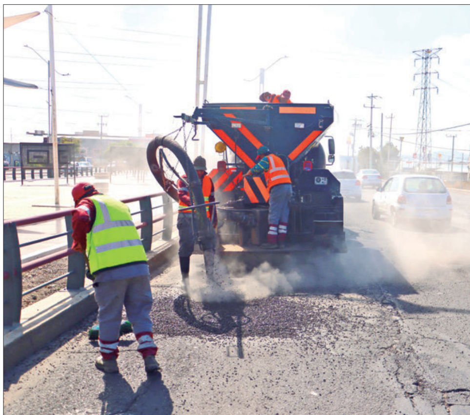
Personal de Obras Públicas del Estado realiza los trabajos de bacheo en el bulevar Río de las Avenidas en Pachuca, esto ante el desgaste de la cinta asfáltica y para evitar que se presente algún incidente vehicular.
