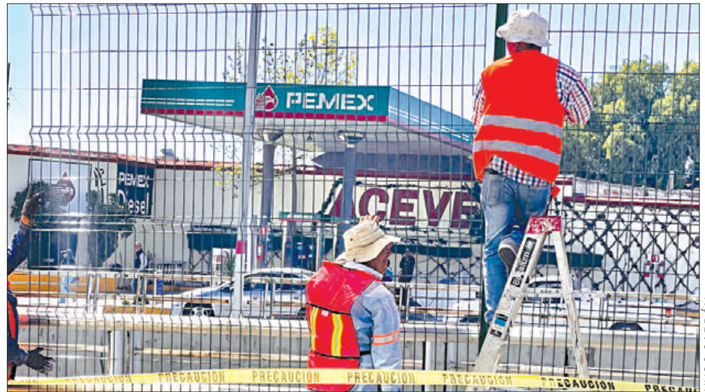
ACTOPAN. El secretario municipal, Juan Manuel Pacheco Cruz, en compañía de la directora de Obras Públicas, Miriam Calva López y personal de Protección Civil fueron los encargados de supervisar la colocación de la reja.
