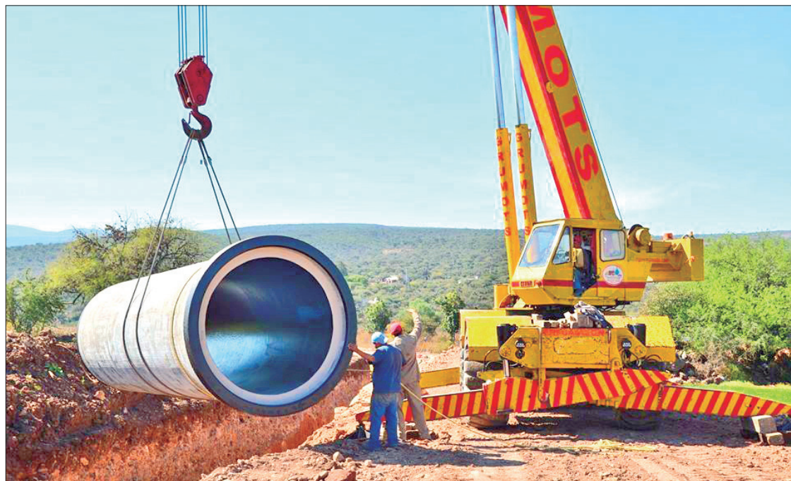
CAMINO. Son visibles los avances en los trabajos del canal de interconexión para la presa El Yathé.
