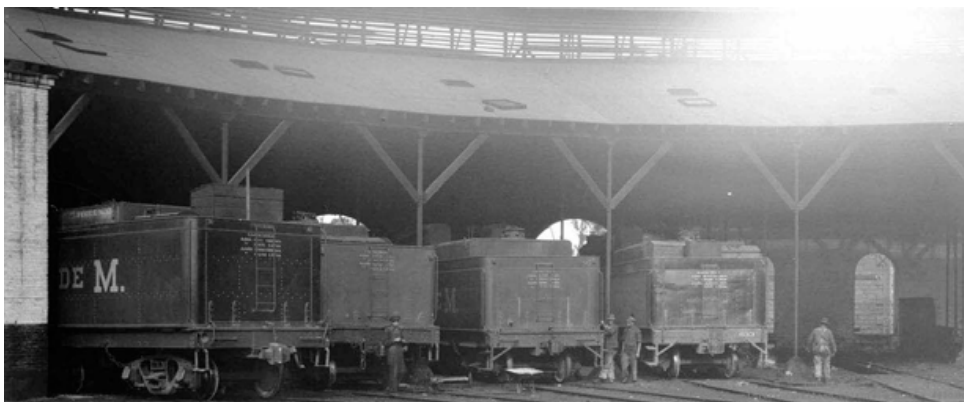
Vista por el extremo norte, de la casa redonda, tabique, columnas rieles, techo madera y ruberoide. Patio de Buenavista.
