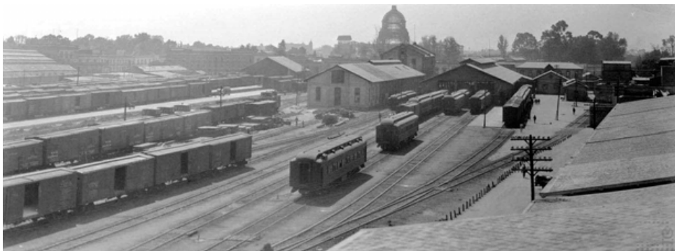
Detalle de vías en el patio de Buenavista y panorámica de los edificios de fuerza motriz, andenes de pasajeros, equipaje, y maestro constructor de carros. Buenavista.
