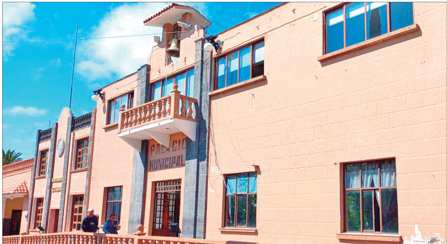
ANTECEDENTE. El pasado miércoles por la tarde, vecinos denunciaron una presunta bodega donde se estarían repartiendo cemento por personal adscrito a la Presidencia Municipal.
