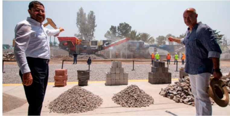
Martí Batres muestra la Planta trituradora.
