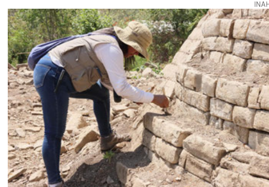
Los trabajos de salvamento.
