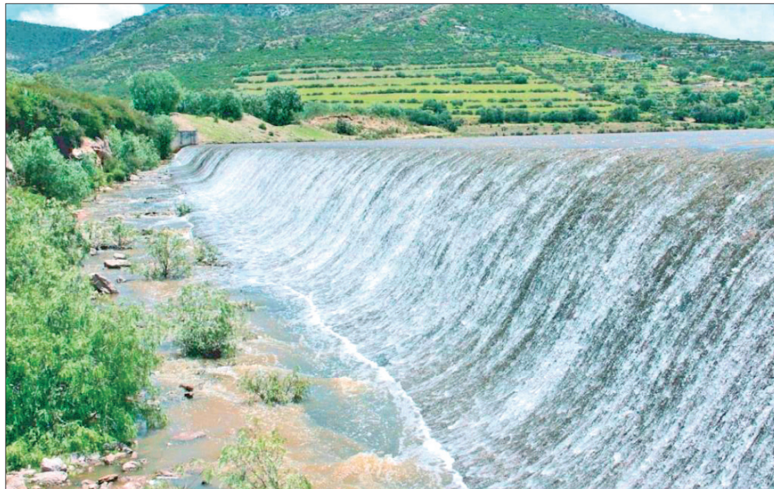
ARISTAS. En conclusión, los cuerpos de agua dentro de la propuesta de la zona de restauración ecológica el área de influencia de la presa Endhó por sí mismos, no tienen la capacidad de diluir y estabilizar residuos y, por lo tanto, no garantiza que reponga de manera natural sus cualidades ecológicas y sanitarias.
