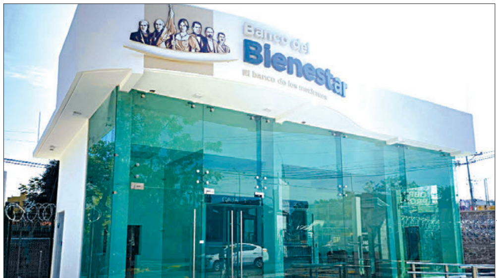
TRUCO. En la bandeja de salida del efectivo se encontraba colocada una trampa que impedía que el cajero entregara el efectivo
