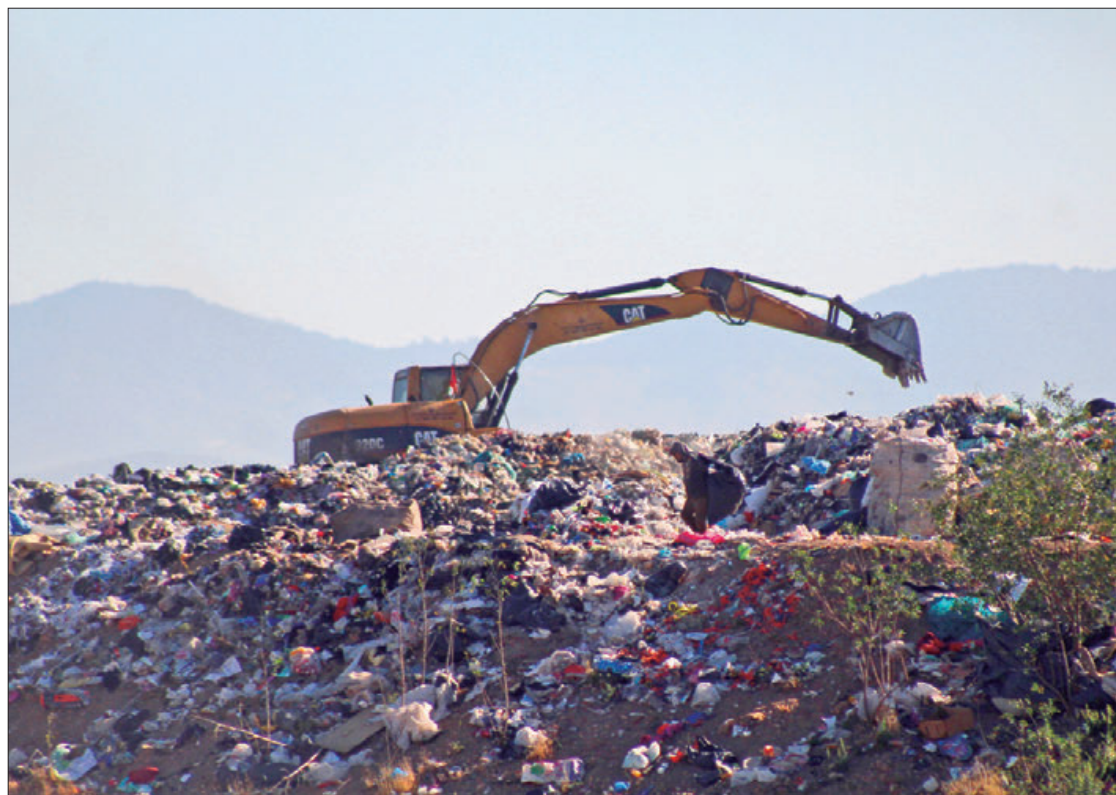
COMPLEJIDAD. El tema se complica al ser el Relleno Sanitario de El Huixmí, insuficiente para el tonelaje diario de basura que recibe.
