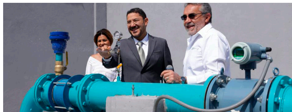
El pozo tiene una profundidad de 350 metros y aportará 40 litros por segundo.
