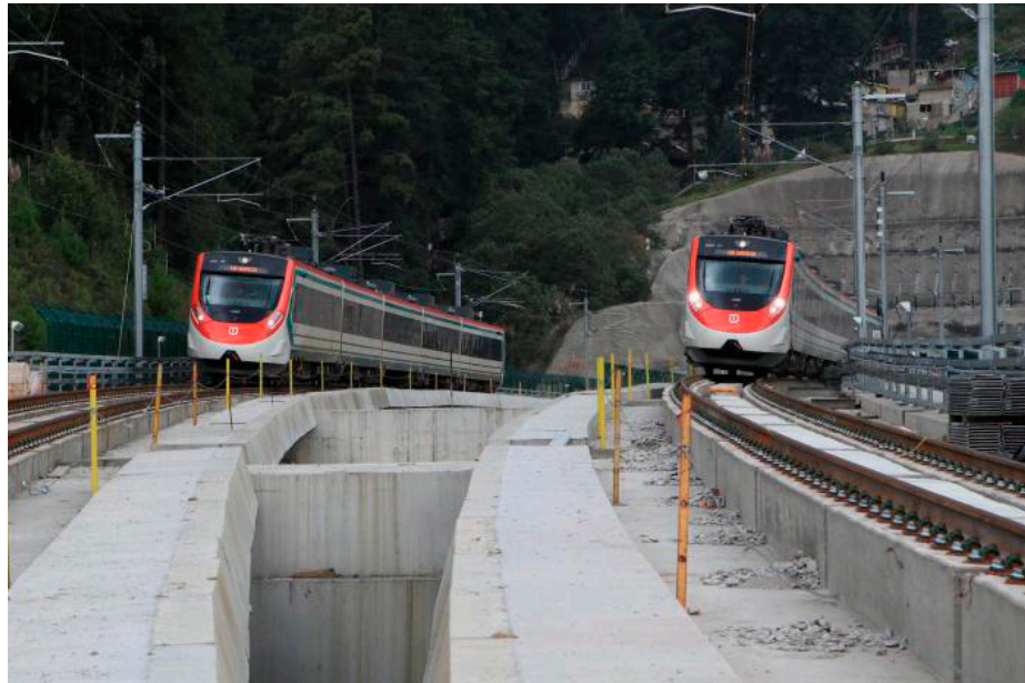
Los trenes fueron cargados con sacos de arena que simulan el peso máximo de los usuarios
