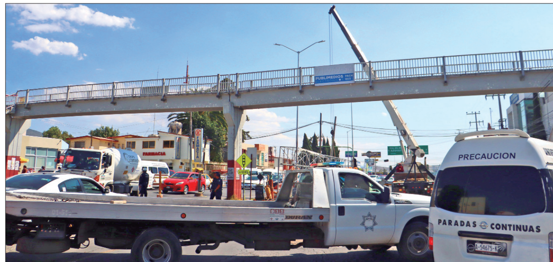
MEJORALITO. Autoridades, en lugar de cambiar un puente peatonal, instalaron cinco topes para garantizar el paso de transeúntes.
