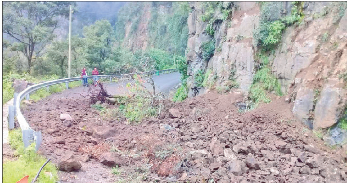
EJEMPLO. Molango, en el kilómetro 129 de la carretera federal, se presentó un derrumbe que obstruía más de un carril, habitantes de la región retiraban parte del material para liberar la zona.
