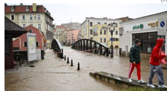
Puente inundado tras el desbordamiento de un río en la localidad Klodzko, Polonia.
