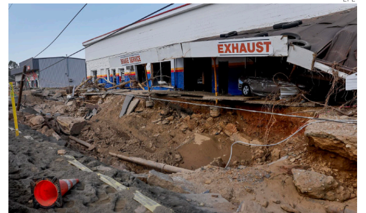
Un taller de autos parcialmente derrumbado por Helene.
