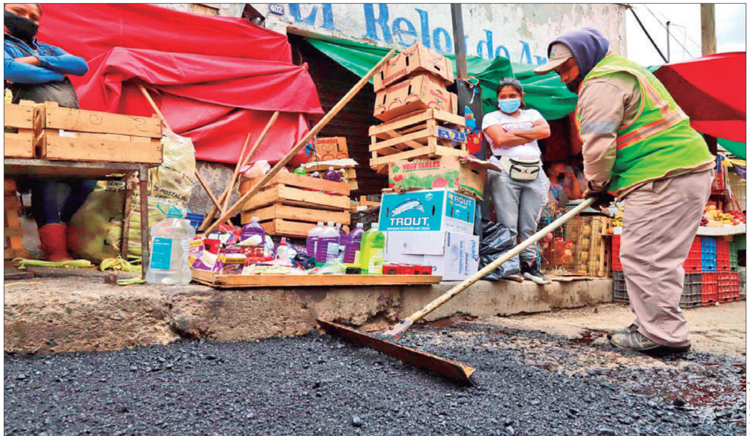
POCO A POCO. Se tiene un considerable avance en otra de las vías de comunicación más desatendidas en los últimos años.
