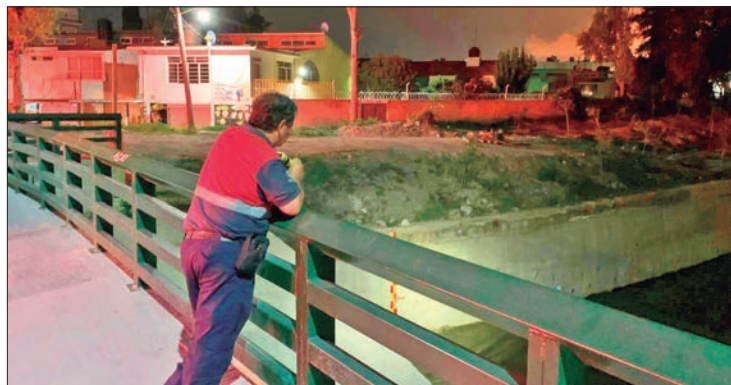
HECHOS. Las obras que ejecutó la Conagua ayudan bastante en esta temporada de lluvias, afirman.
