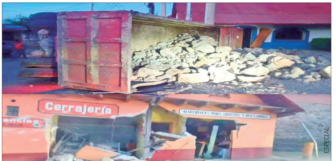
MINERAL DEL MONTE. Debido a una posible falla mecánica, un tráiler impactó contra un negocio y derribó el cableado electrónico. De acuerdo con la Policía Municipal, dicho percance se presentó en el acceso principal, donde la pesada unidad se quedó sin frenos: la energía eléctrica fue suspendida en gran parte del municipio. El conductor resultó lesionado.
