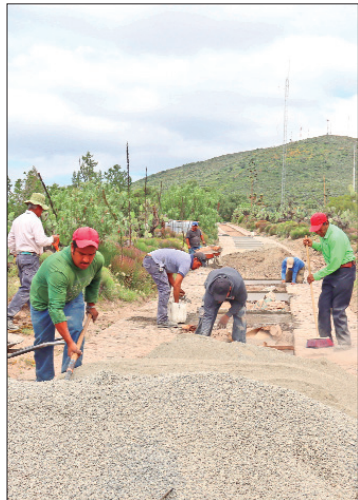
ACCIONES. Los trabajos incluyeron la recuperación de mil 800 metros lineales de pavimentación.
