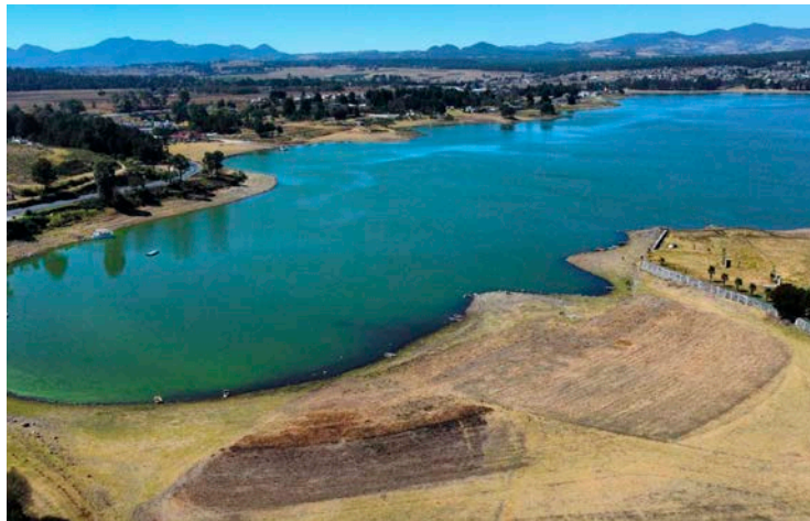
Presa "Miguel Alemán Valdés" ubicada en Valle de Bravo.
