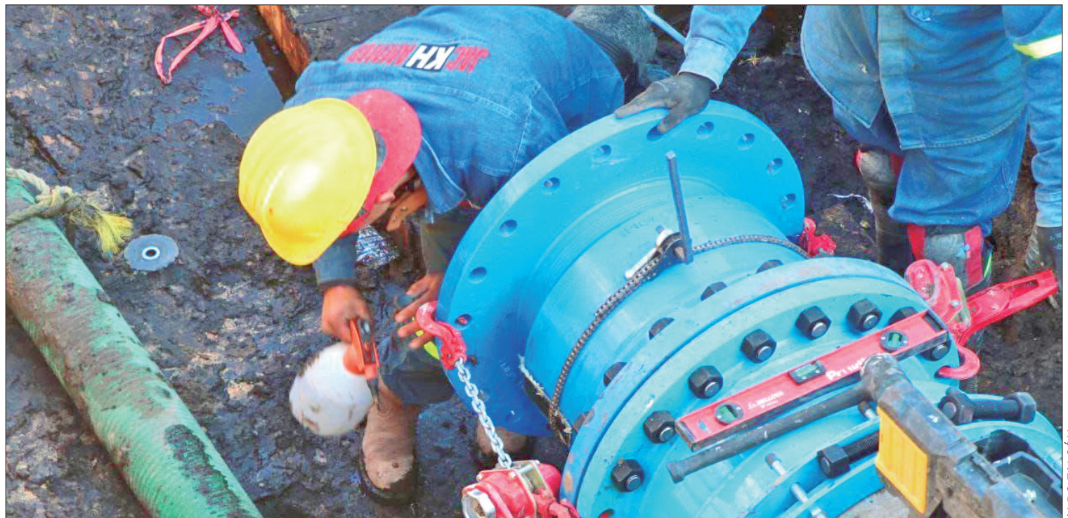
TÉCNICAS. También se realizó el blindaje del conducto, al insertar la tubería flexible, reforzada, inflado y sellado del ducto.
