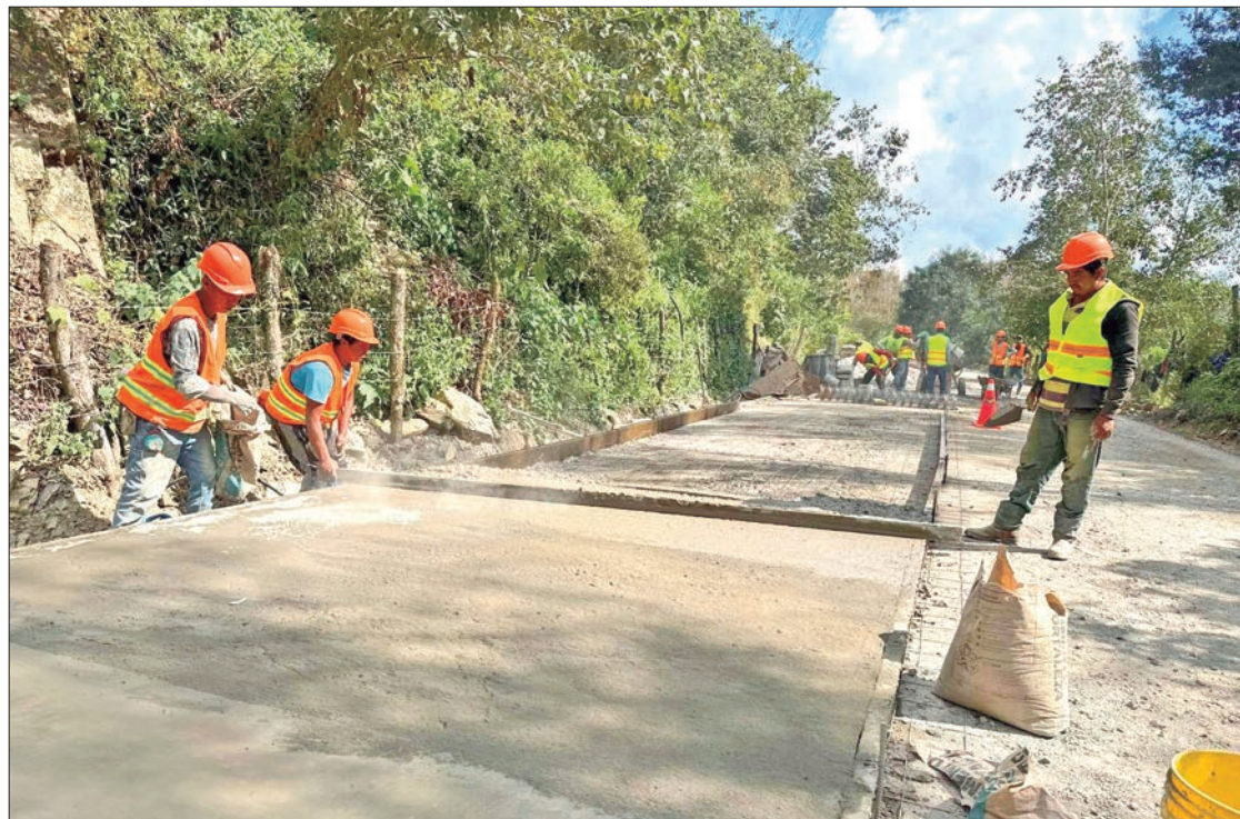
PREMISA. Recordó que como parte de los procesos de entrega-recepción en las presidencias municipales, algunos alcaldes entrantes denunciaron ciertas anomalías en proyectos de infraestructura, principalmente fallas en la ejecución o incumplimiento de especificaciones por parte de los proveedores.
